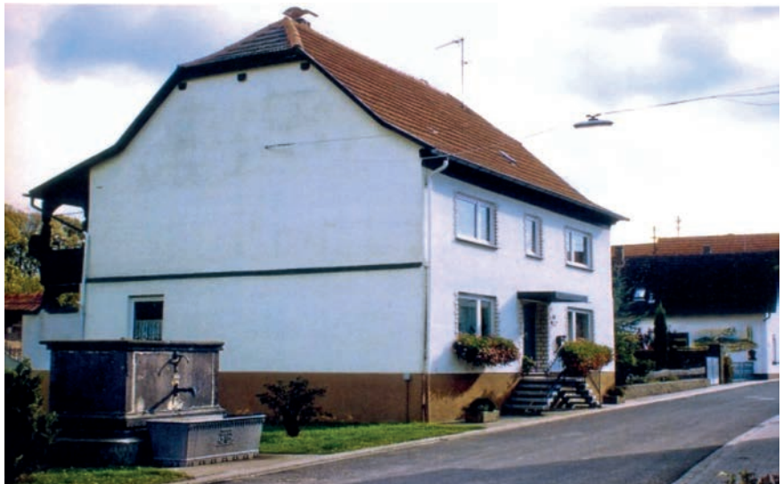
Das Försterhaus in der Hochstraße. in dem von 1827 bis 1936 nacheinander vier Waldalgesheimer Förster wohnten
